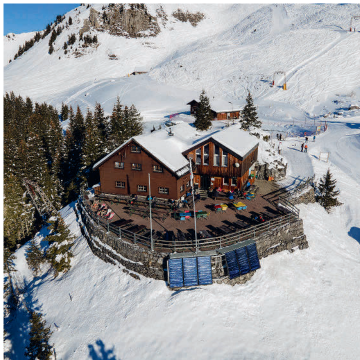
Nach 93 Jahren im Besitz der SAC Sektion Engelberg haben die Brunni-Bahnen Engelberg AG die Brunnihütte übernommen.
