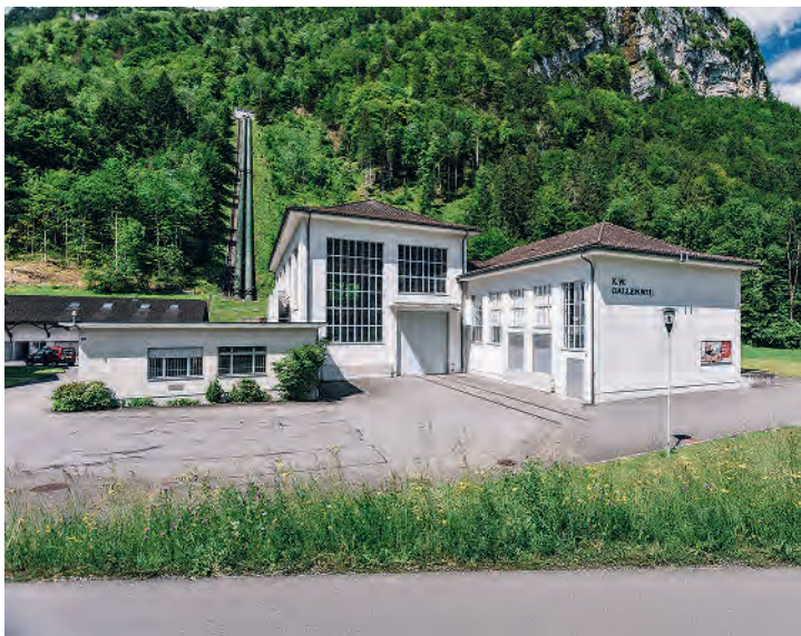
Aussenansicht Wasserkraftwerk Dallenwil
