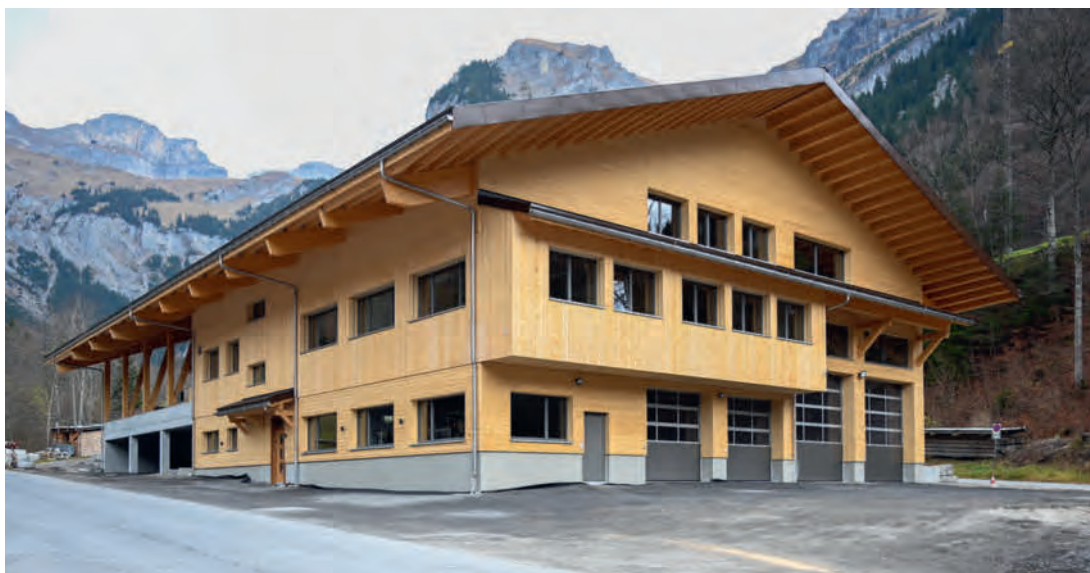
Viel Holz. Das für den neuen Forstwerkhof der Bürgergemeinde in Engelberg verarbeitete Holz stammt zu 87 Prozent aus Schweizer Wäldern.
