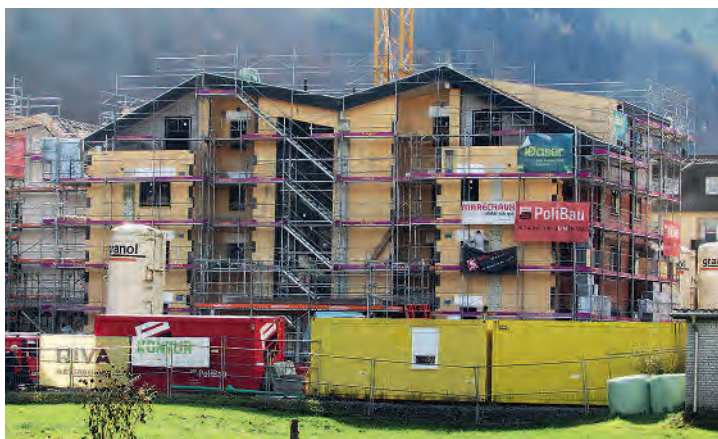
Der noch eingerüstete Neubau der Stiftung Wohnen und Arbeiten.
