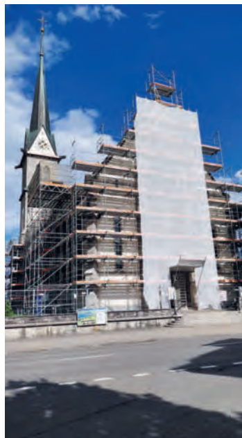
Die eingerüstete Pfarrkirche Ennetbürgen
